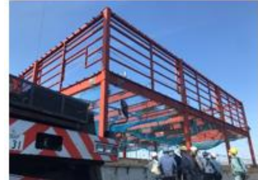
工事監督補助業務 （鉄骨建て方精度確認）
