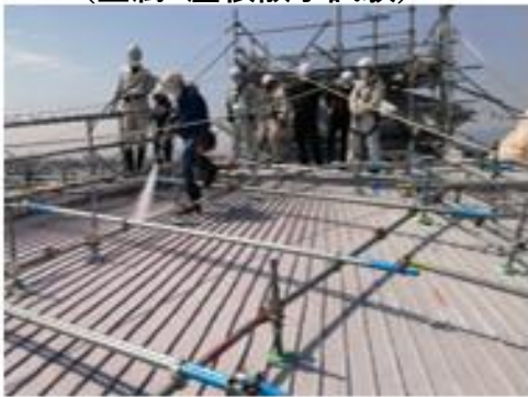
工事監督補助業務 （金属R屋根散水試験）
